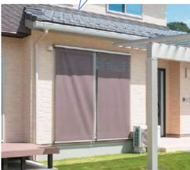
窓の外で日射熱をブロックするのに効果的なのが、アウターシェード(日よけ)。高断熱の樹脂窓と合せてアウターシェードを用いることで、日射熱を9割以上カットできます。
